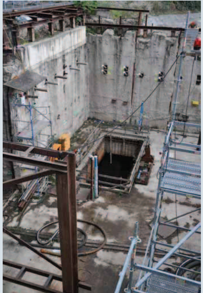
Zwaar verstevigde bouwput op de plaats waar tot begin 2009 het stadsarchief van Köln gevestigd was, gebouwd om de archiefdocumenten van het ingestorte stadsarchief te bergen.
