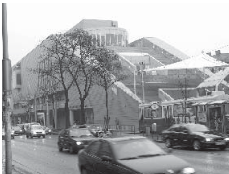
De nieuwe bibliotheek werd gebouwd boven de sleuf waar de metro door rijdt. Foto: Marc Storms.
