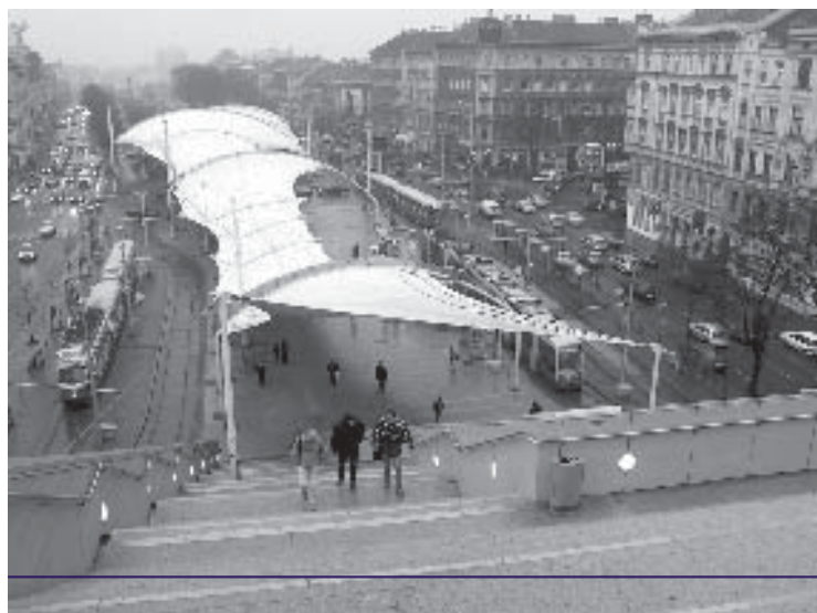
De tramplaat onder een sierlijke tentconstructie leidt naar de Weense hoofdbibliotheek. Foto: Marc Storms.
